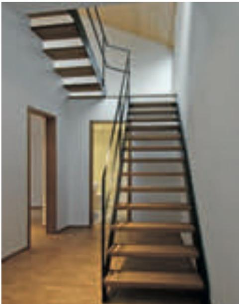
Grösstes Problem war die Belichtung des ehemaligen Stalles: aus dem hellen Raum unter dem Dach fällt durch das offene Treppenhaus Licht bis ins erste Obergeschoss.
