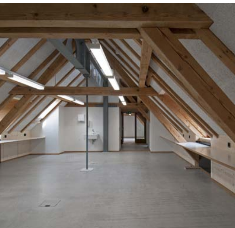
Der Dachstock kann als Campus genutzt werden.
